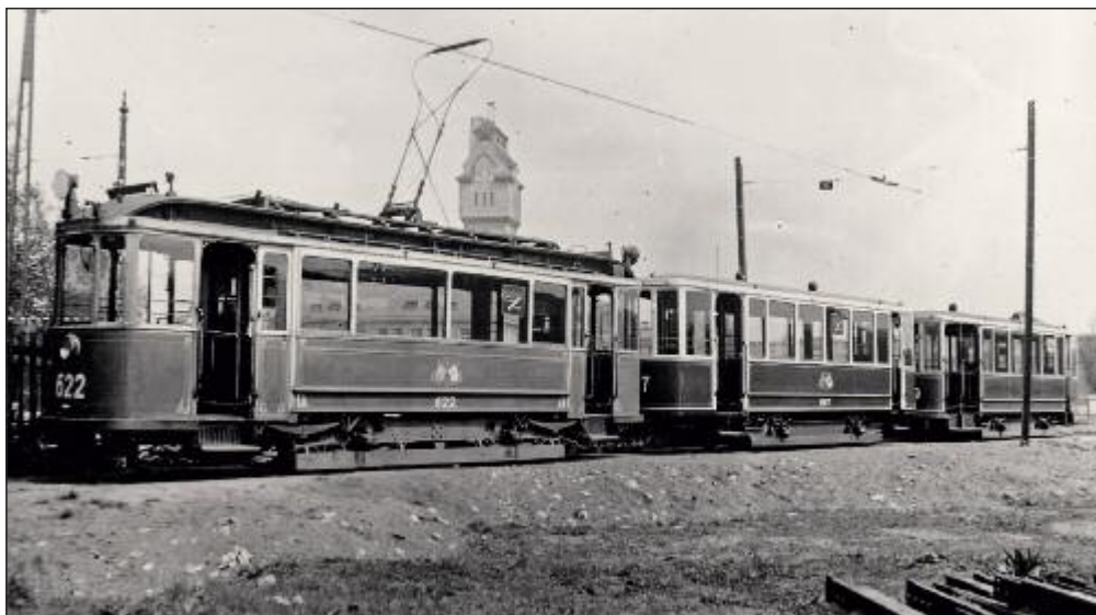
Ein typischer Zug mit den Beiwagen 1017 und 1029 am Gleislagerplatz der ehemaligen Hauptwerkstatt Muggenhof.
